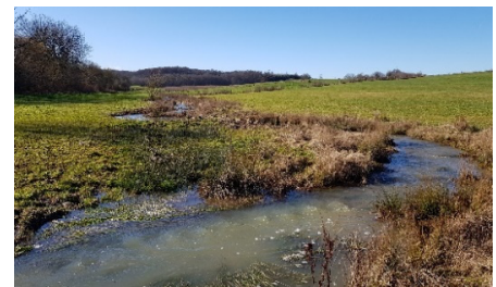
Baachrenaturéierung am Klenggewännchen
