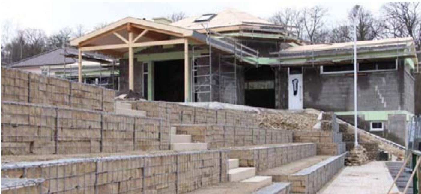
Freizeitgelände „Schwéngsweed“ kurz vor der Fertigstellung
